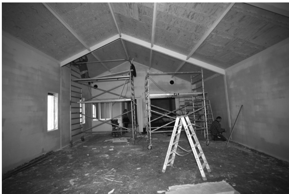
Werk in uitvoering in Cabauw
